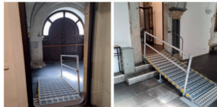
Mobile Rampe in der Vorhalle von St. Andreas, Köln | Foto: Daniel Stadtherr (17.07.2024)
